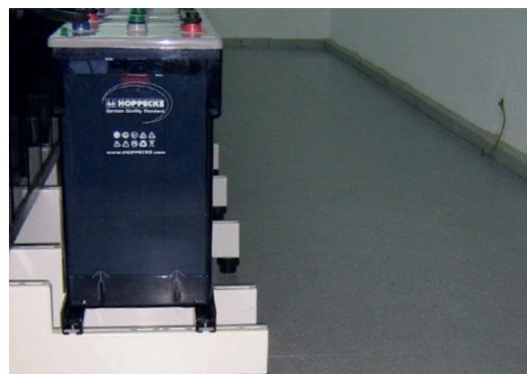
nach der Renovierung after the renovation
