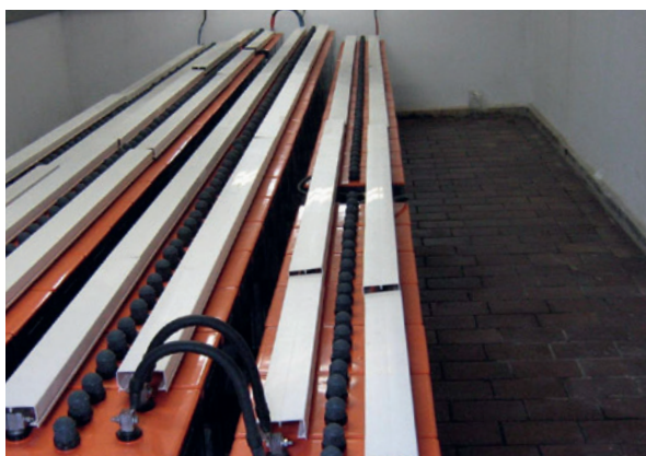
vor der Renovierung before the renovation
