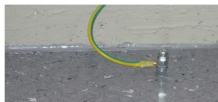
einfacher Anschluss der Erdungspunkte easy connection of grounding points
